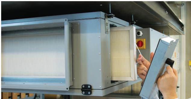
› **Filterwechsel.** Die Filterbelastung wird durch Druckschalter oder Timer überwacht. Filter sind leicht rückstellbar: In der CXP-Baureihe ist auch keine Notwendigkeit, die Abdeckung abzunehmen. Es ist sehr wichtig, wenn das Gerät unter der Decke hängt.
